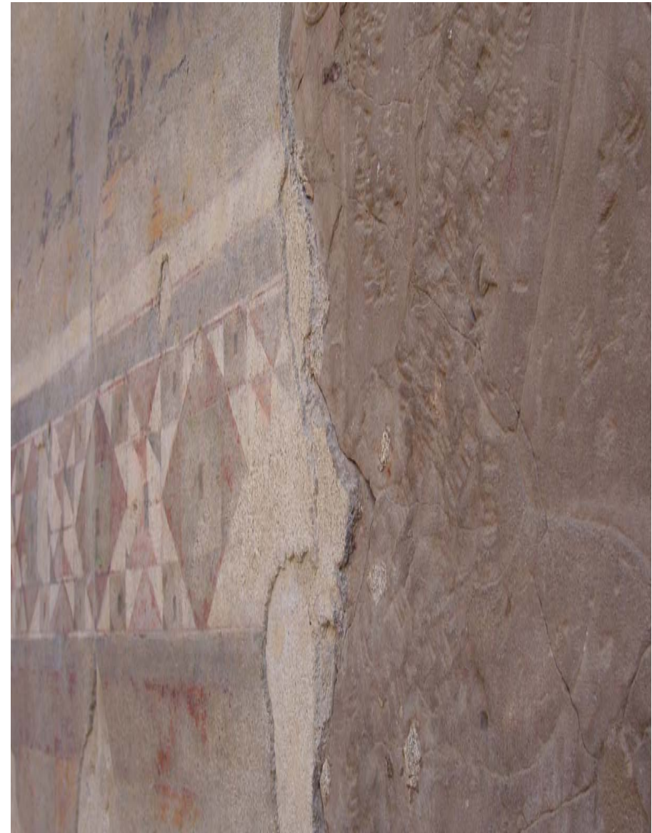
Przekrój malowidła ściennego
