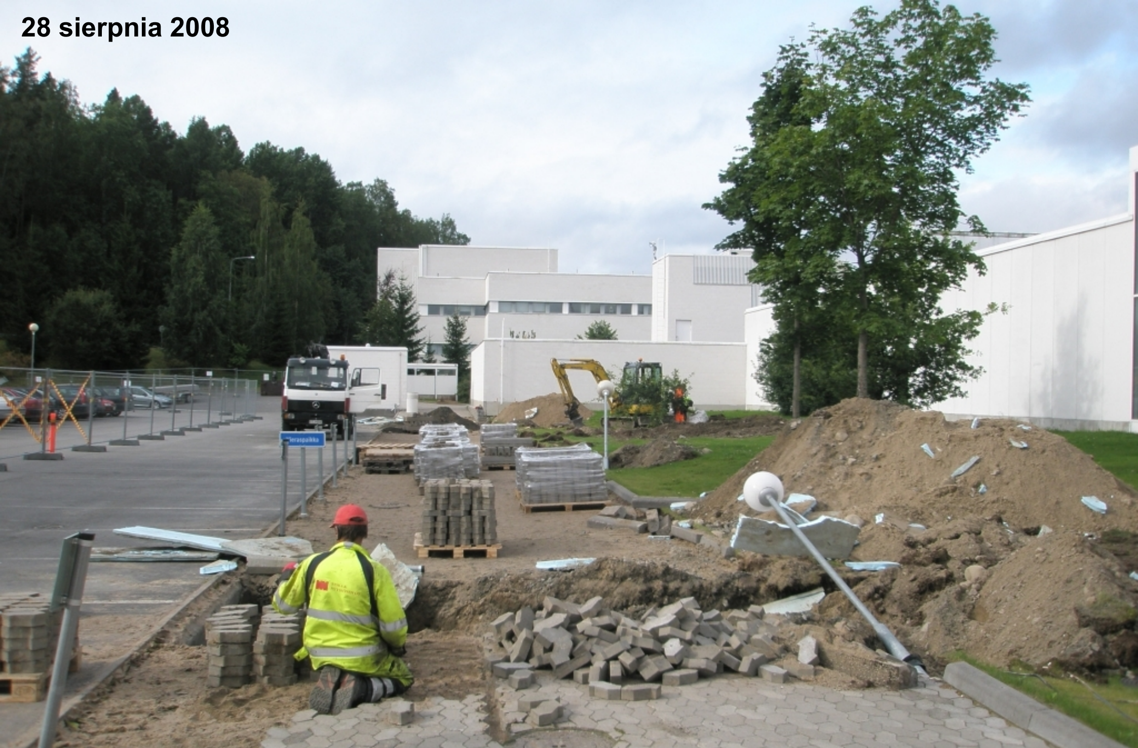
początek prac przy budowie hali dla nowego cyklotronu i separatora IGISOL
